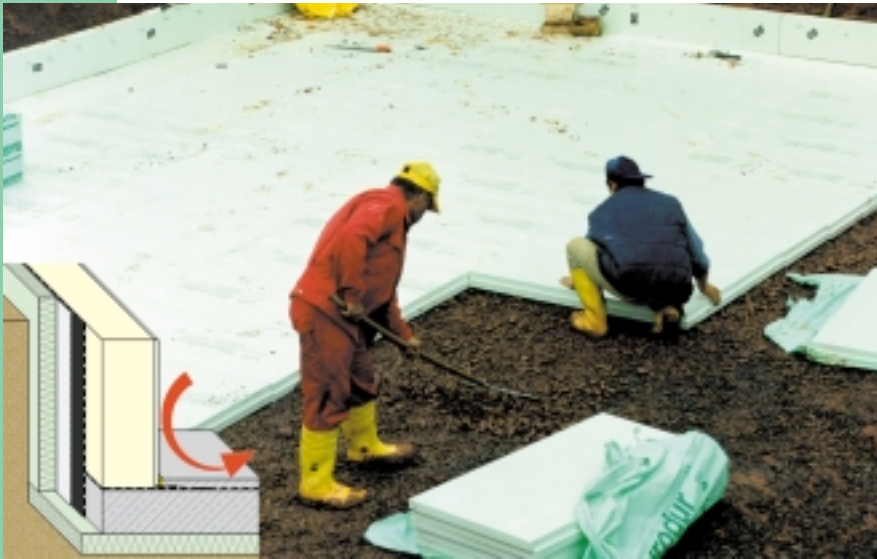
Eine um das Fundament geführte lastabtragende Kellerdämmung verhindert Wärmebrücken
