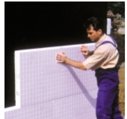
Eine um das Fundament geführte lastabtragende Kellerdämmung verhindert Wärmebrücken
